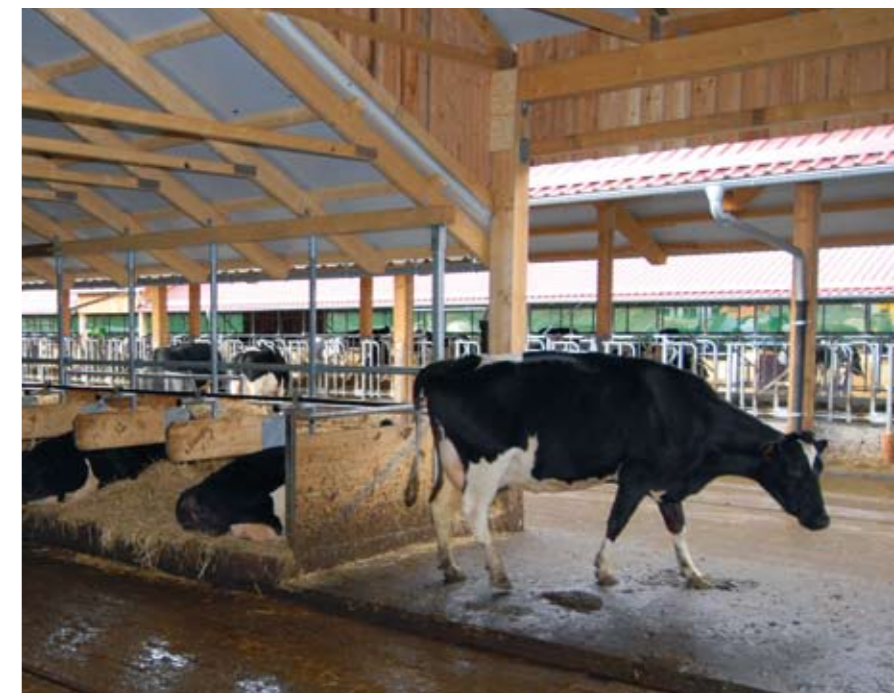
› Der erste Bauabschnitt des neuen Kuhstalls in Juchowo
